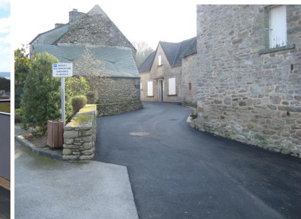
Les derniers travaux réalisés
